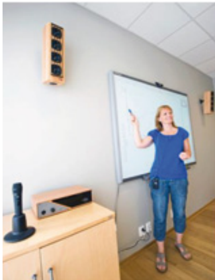
Figur 4. Audiolink-basenhets installation tillsammans med två pelarhögtalare för jämn ljudfördelning i rummet. Källa: Vestfold Audio a.s.
